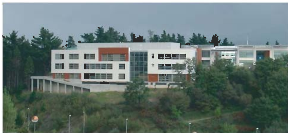
Oficinas centrales "DHL". San Sebastián
